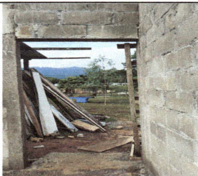
Foto 13. Módulo 6: Colocación de puerta al área de cocina, lado frontal.
