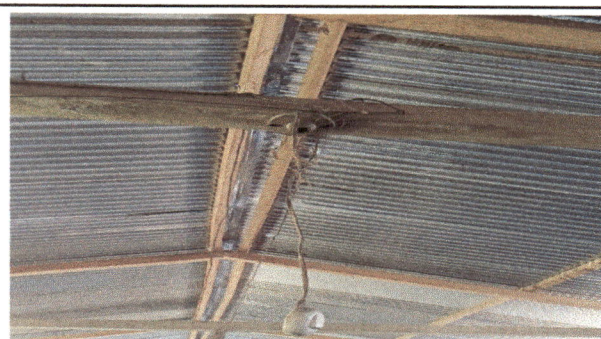
Foto 6: Módulo 3. Sustitución de sistema eléctrico por deterioro (parte interior de los módulos a remozar)
