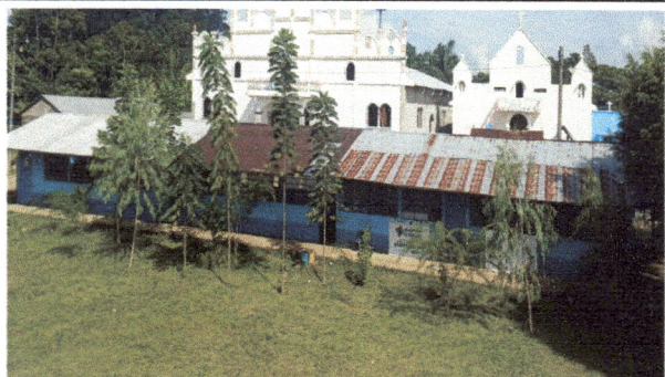
Foto1. Módulo1: Sustitución de láminas acanaladas por láminas troqueladas, debido al deterioro. (Parte frontal de los módulos a remozar).
