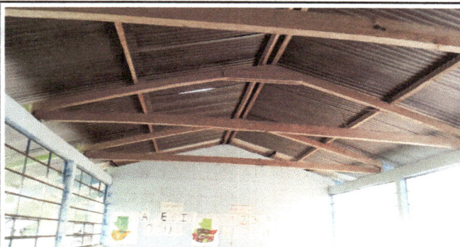
Foto 3. Módulo 1: Interior de los módulos de aulas a sustituir lámina acanalada, por láminas troqueladas.
