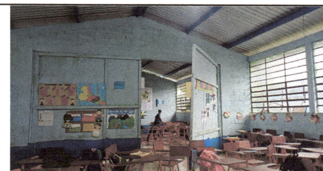
Foto 12. Módulo 5: Segundo panel divisor de aula de madera a sustituir por división metálica, debido al deterioro y mala condición estructural. (Aula de Sexto Primaria)
