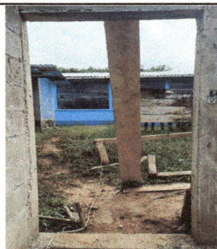
Foto 14. Instalación de puerta al área de cocina, del lado posterior.
