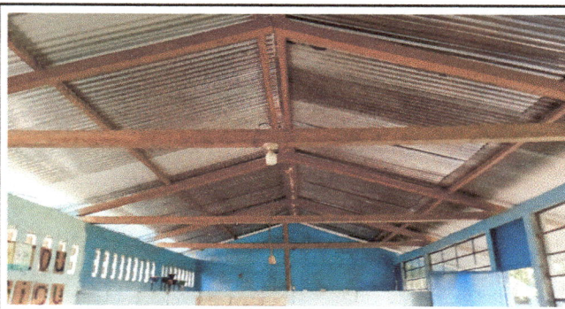
Foto 4. Módulo 2: Sustitución de estructura de madera por estructura metálica. (Interior de los módulos a remozar).
