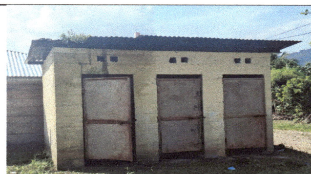
Foto 10. Módulo 4: Mantenimiento de pintura en muros interior y exterior del servicio Sanitario.
